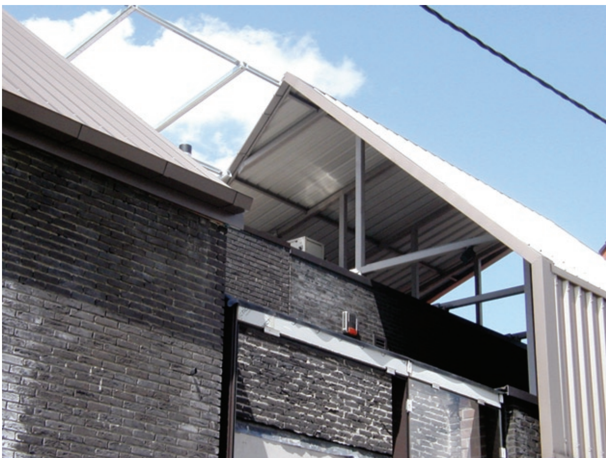
VARIANTE: EEN ZWEVEND SCHADUWDAK UITVOEREN ALS ZADELDAK.
