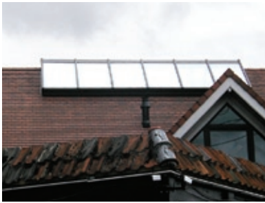
EEN BIOKLIMATISCHE ZONDE: EEN LICHTSTRAAT IN DE NOK.
