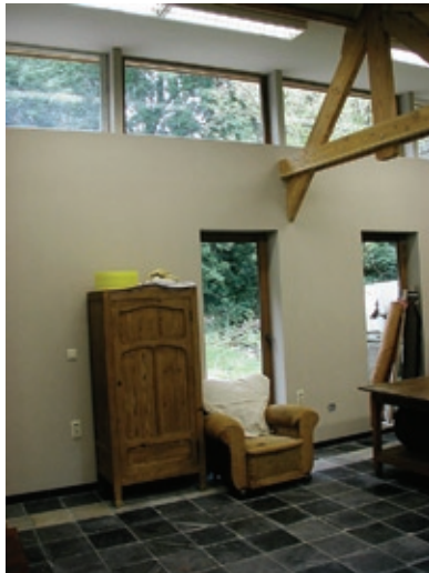
ZO GAAT HET GOED: EEN CLERESTORY (DAKLICHT, LICHTBEUK) OP HET NOORDEN.
