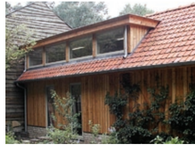
ZO GAAT HET GOED BIS: EEN CLERESTORY (DAKLICHT, LICHTBEUK) OP HET NOORDEN.
