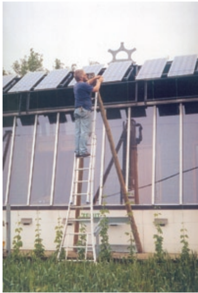
DE VERTICALE HOPPEDRADEN WORDEN MET EEN HOPPEKNOOP BEVESTIGD AAN DE BOVENSTE HORIZONTALE STAALDRAAD.
