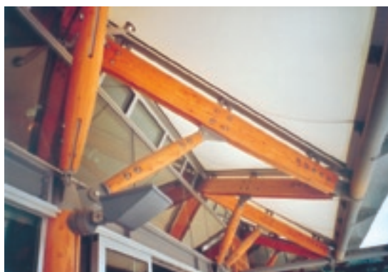
HOUTVERBINDING MET METALEN TUSSENSTUKKEN.
