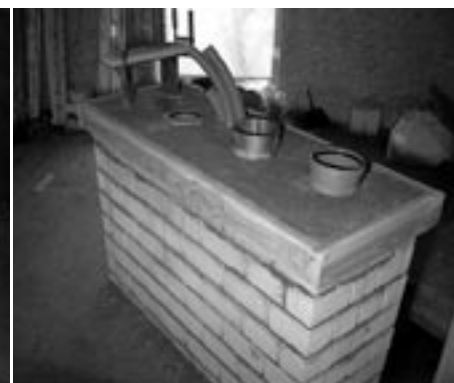
HET AFGEWERKTE METSELWERK
