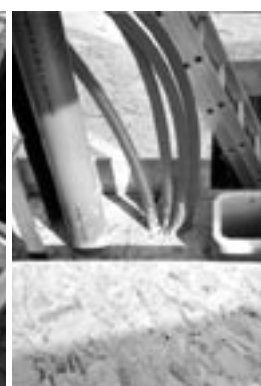
WE BEREIKEN DE EERSTE VERDIEPING. LINKS KRIJGT DE AFVOER VAN DE VENTILATIELUCHT (KEUKEN, DOUCHE, WC) BOVENAAN IN KANAAL 1 EEN PLAATJE IN DE CENTRALE KOKER. ER WAS ZELFS NOG VOLDOENDE PLAATS VOOR VIER WACHTBUIZEN.
