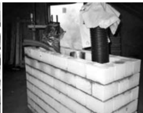
EINDE VAN HET METSELWERK OP DE EERSTE VERDIEPING.
