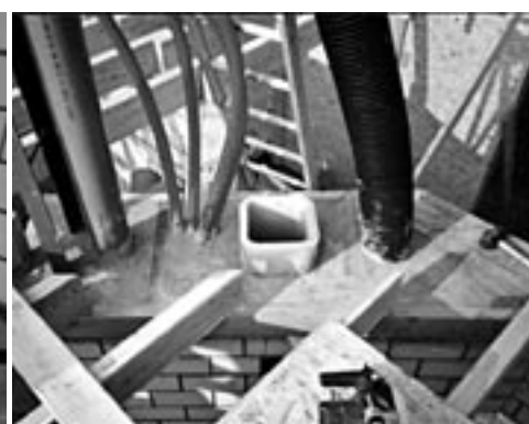
WE BEREIKEN DE EERSTE VERDIEPING. LINKS KRIJGT DE AFVOER VAN DE VENTILATIELUCHT (KEUKEN, DOUCHE, WC) BOVENAAN IN KANAAL 1 EEN PLAATJE IN DE CENTRALE KOKER. ER WAS ZELFS NOG VOLDOENDE PLAATS VOOR VIER WACHTBUIZEN.
