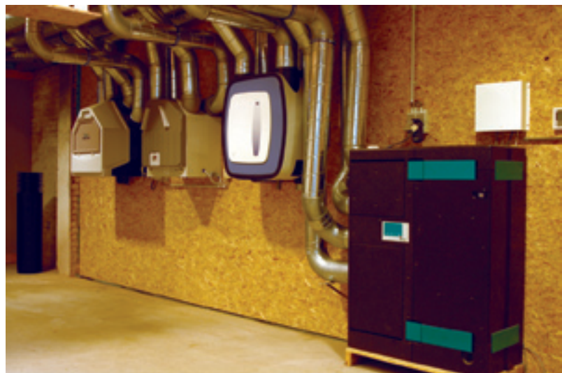
VAN VOOR NAAR ACHTER: DE PAUL-LUEFTUNG BALANSVENTILATOR, DE ITHO BALANSVENTILATOR, DE STORK-AIR BALANSVENTILATOR EN DE ORCON BALANSVENTILATOR.
