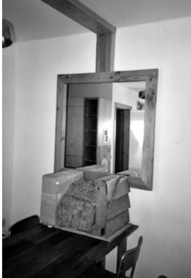
OVER HET PLAFOND LIGT EEN HOUTEN U-PROFIEL OM DE VERLICHTINGSKABELS OP TE BERGEN. OP DE TAFEL STAAT EEN DOORSNEDE VAN DE MUUROPBOW.
