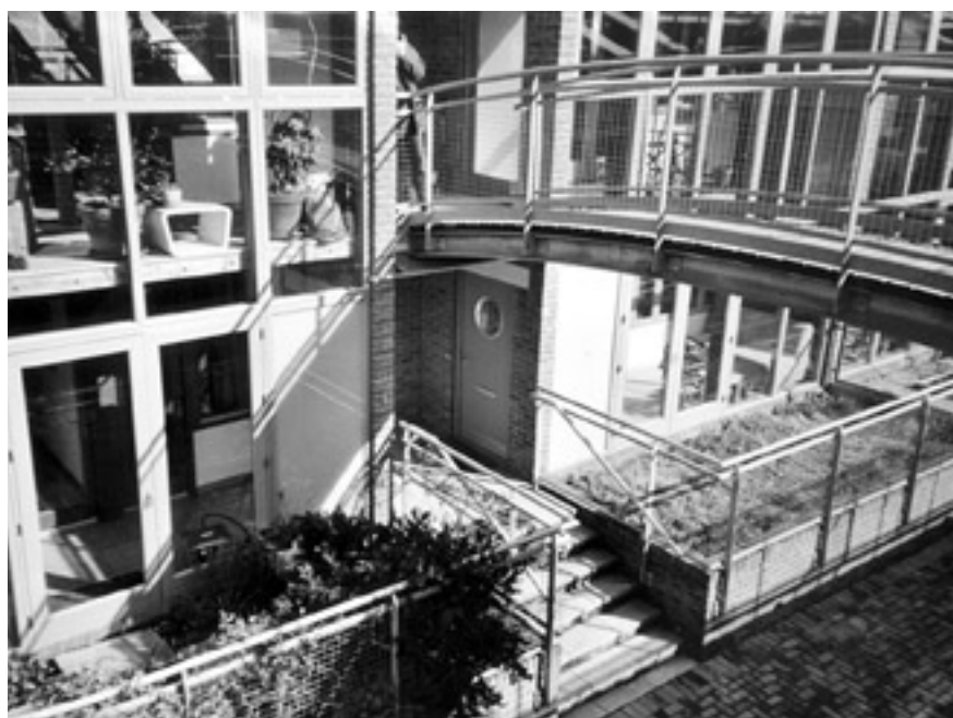
EEN BRUGGETJE BRENGT JE NAAR DE DAKTUIN LANGS DE OVERKANT.
