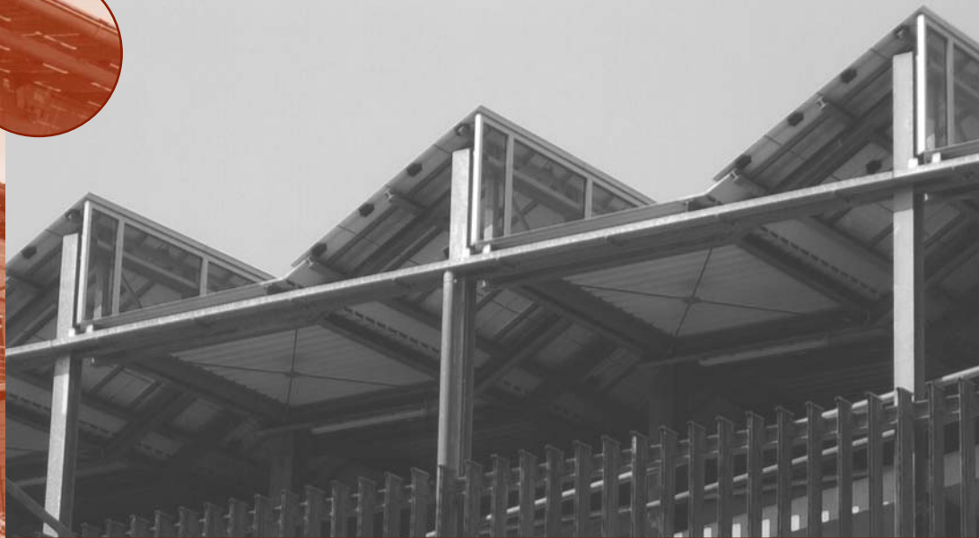
ZAAGTANDDAK VAN DE SOLAR GARAGE IN DE VAUBAN WIJK.
